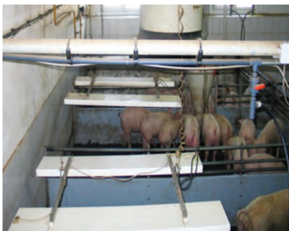
Расположение ИК-излучателей над станками с поросятами-отъемышами
