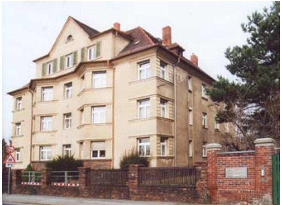
Abb. 33 Radebeul, Pestalozzistraße 13, vor der Sanierung
