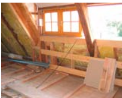
Abb. 8 Ausbau Dachgeschoss, Zwischensparrendämmung aus Glaswolle
