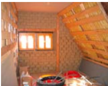
Abb. 7 Lehmündämmung aus Lehmbausteinen
