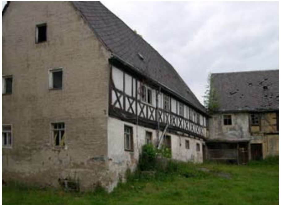
Abb. 17 Nossen, Hauptstraße 33, vor der Sanierung
