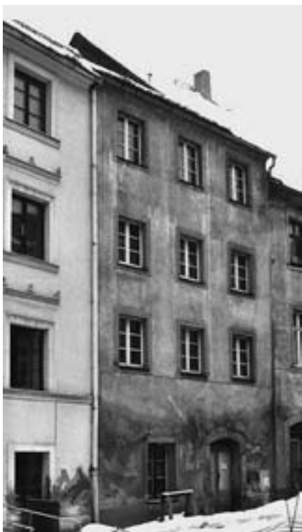
Abb.1 Görlitz, Handwerk 15, vor Sanierung
