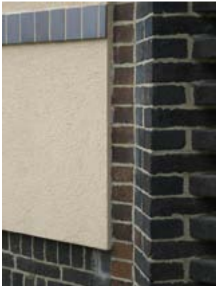
Abb. 37 Fassade, Dämmputz mit nachgebildetem Simsband aus aufgeklebten Klinkerplatten (schwieriger Kompromiss)
