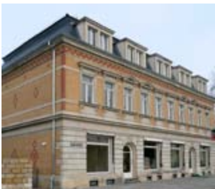
Abb. 16 Radebeul, Robert- Werner-Platz 6, nach der Sanierung: Weitestgehender Erhalt von Substanz und Erscheinungsbild der Fassade
