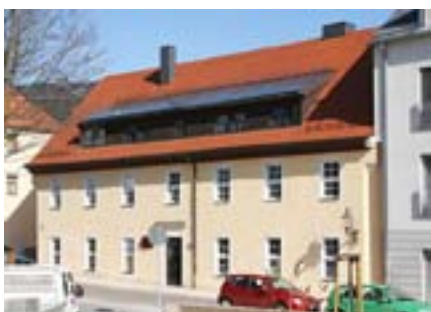
Abb. 11 Freiberg, Helmertplatz, Photovoltaikanlage auf der Dachgaube, Oberste Geschossdecke und Kellerdecke
