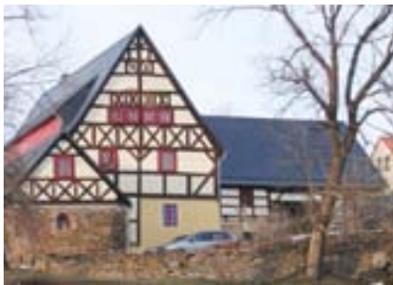
Abb. 9 Nossen, Hauptstraße 33, ein gelungenes Beispiel der Integration einer Photovoltaikanlage auf dem Dach der Scheune
