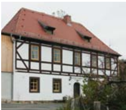
Abb. 5 Radebeul, Bischofsweg 30, vor Sanierung
