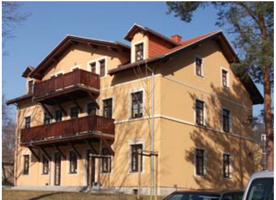
Abb. 22 Dresden, Bautzner Str. 183, nach der Sanierung
