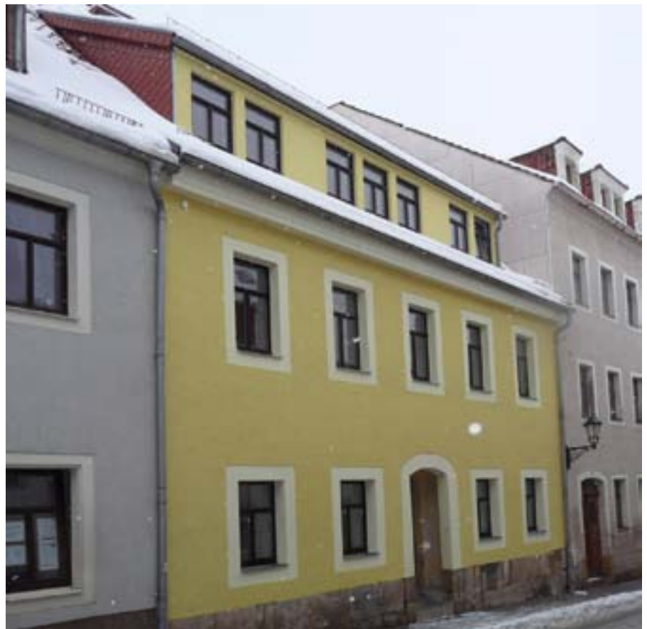
Abb. 25/26 Dippoldiswalde, Große Wassergasse 8, vor und nach der Sanierung
