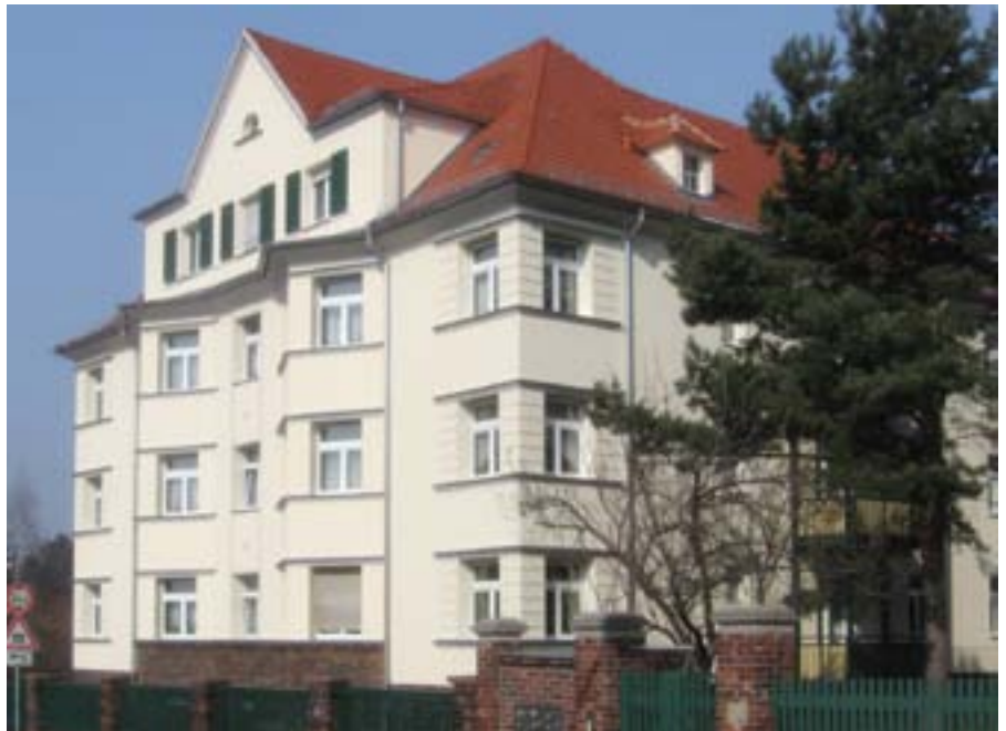
Abb. 34 Radebeul, Pestalozzistraße 13, nach der Sanierung
