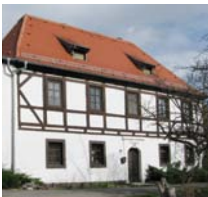
Abb. 6 Radebeul, Bischofsweg 30, nach Sanierung
