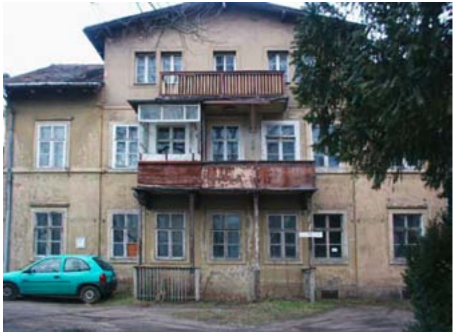
Abb. 21 Dresden, Bautzner Str.183, frei stehendes Mietshaus vor der Sanierung
